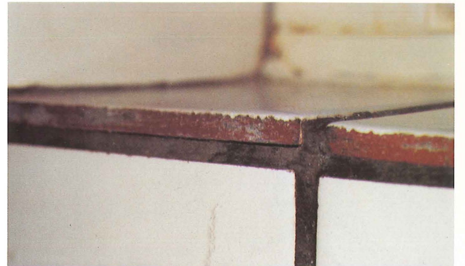
Svigt i brystningsparti (omtalt side 18)
